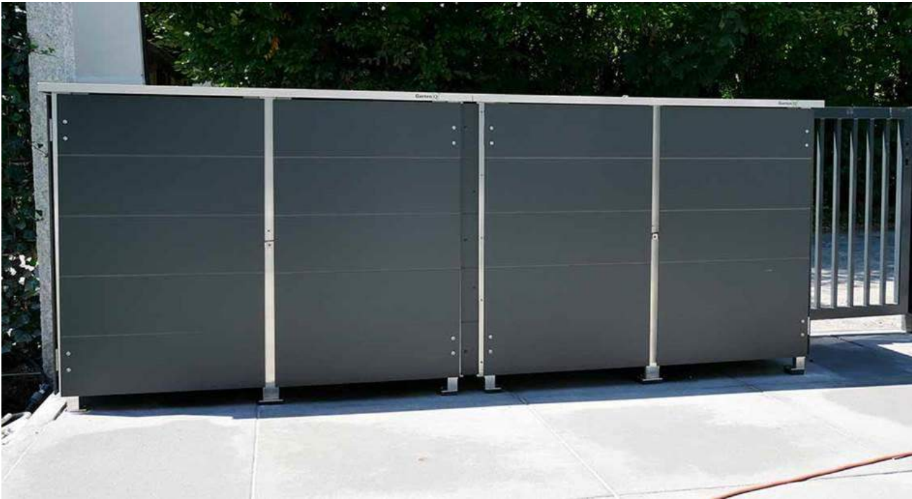
Bild 4: Ausgleich 2,4 cm; Könnte noch auf insgesamt 6 Module (3,2 cm), fortgesetzt werden.
